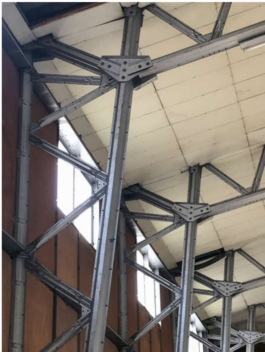
Détail de l'assemblage à sec des cadres structurels creux et triangulés. 28.04.2021.
